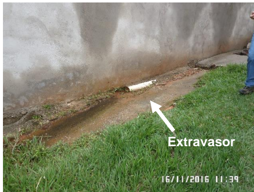
Figura 6.18 – Dreno localizado a jusante do Lago 1
