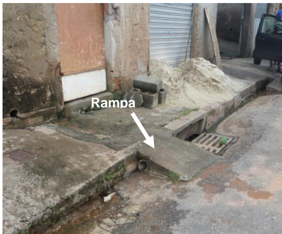
Figura 6.20 – Rampa de concreto a ser demolida
