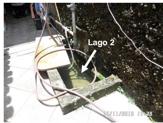
Figura 6.17 – Lago 2: Bombeamento de água para o uso doméstico
