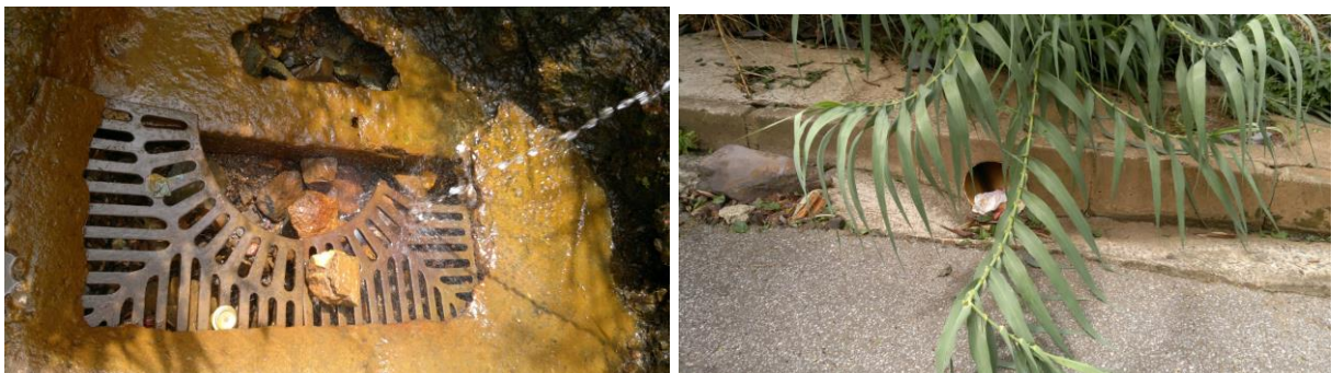
Figura 6.12 – Grade existente na propriedade e saída da drenagem para a sarjeta
