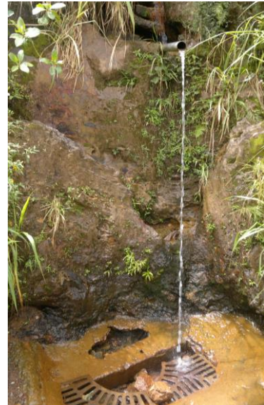
Figura 6.11 – Detalhe da nascente AR-120 canalizada
